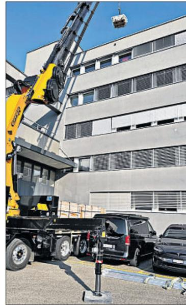
Die PV-Module werden auf das Dach gehoben.
