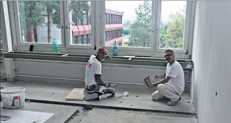
Die Gipser sind ebenso am Arbeiten...
