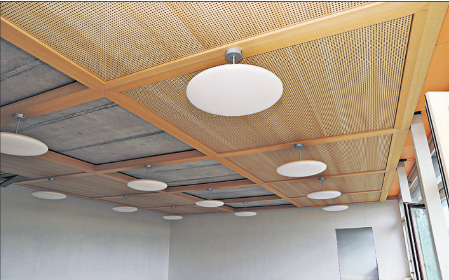
Im Musterzimmer ist bereits die Akustikdecke und die LED-Deckenbeleuchtung montiert worden.
