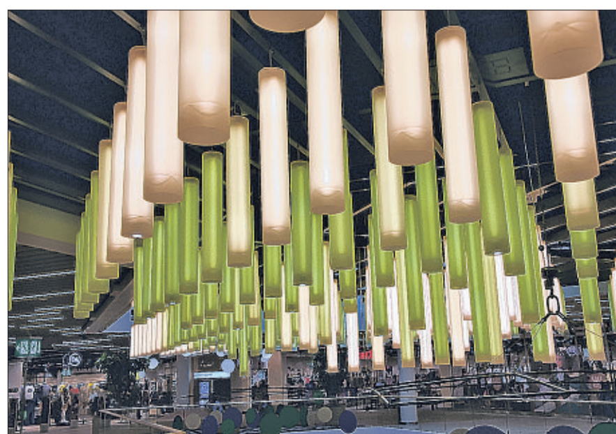
Die Beleuchtung auch als Blickfang.
