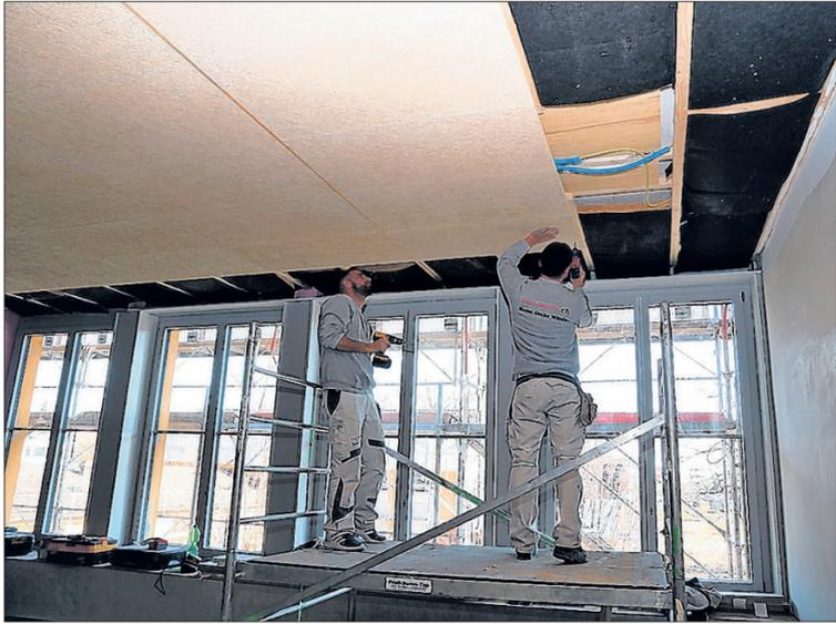
In den Schulzimmern werden die Deckenverkleidungen montiert.
