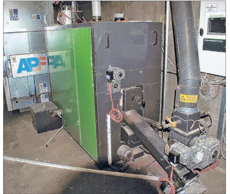
Die neue Heizung, der Heizomat, im Hintergrund der neue Feinstaubfilter.
