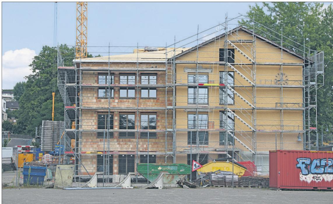
Der Dachstuhl beim Anbau ist errichtet – nun kann das Dach eingedeckt werden.
