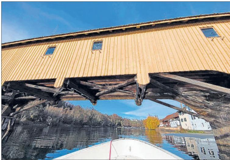
Bei der **gedeckten Rheinbrücke in Rheinau** handelt es sich um eine der heute seltenen **Pfahljochbrücken** und die darf nur von Fahrzeugen mit einem Höchstgewicht von 8 Tonnen befahren werden.
