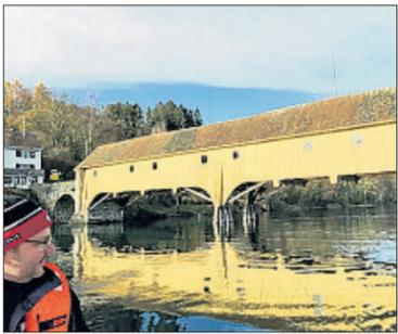
Grössere Instandsetzungsarbeiten wurden 1885, die auch eine Verstärkung der Konstruktion umfasste, und 1918 bis 1930 mit Arbeiten an den **Pfahljochen** durchgeführt. 1953 wurde starker Befall der Holzkonstruktion mit Hausbock festgestellt und es kam zu einem Austausch der stark beschädigten Bauteile.
