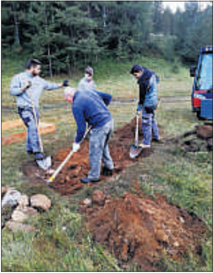
Verschiedenste Arbeiten sind geplant! Zaun bauen, Grillstellen erstellen.
