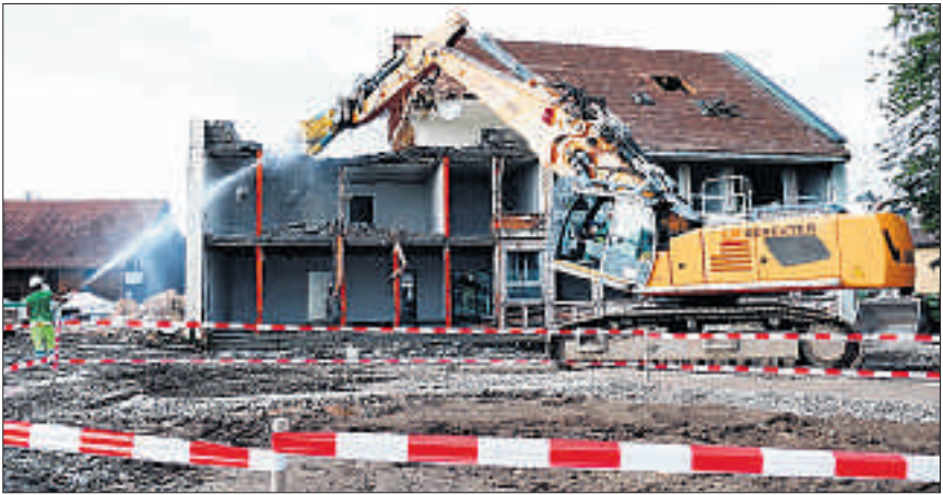
Das alte Gemeindehaus muss der neuen Überbauung «Voilà» Platz machen.
