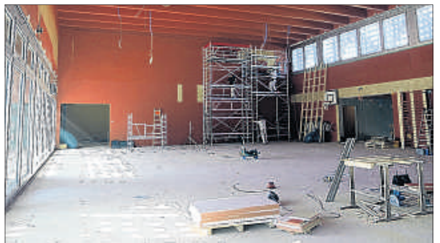
Blick in die neue Turnhalle auf dem Trakt C. Hier wurde mit der Montage der Turngeräte begonnen.
