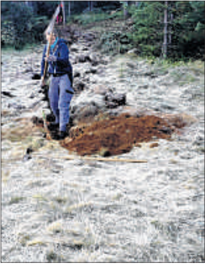
Wasserleitung zu Grillstelle erstellen.
