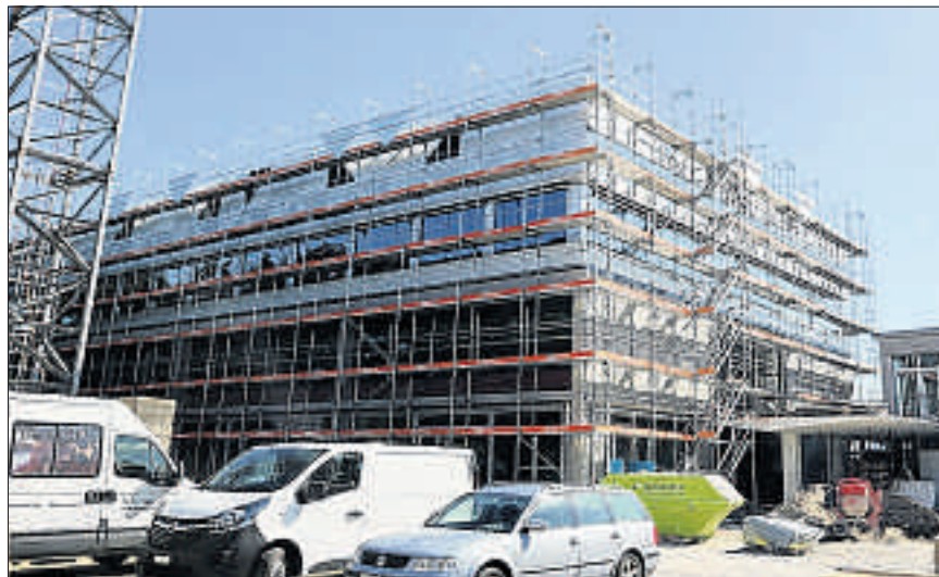
Beim Fototermin noch eingerüstet: Der Trakt A mit dem aufgestockten, zweiten Obergeschoss, welches oben eine Alu-Fassade erhalten hat. Bilder: Beatrice Zogg/zvg
