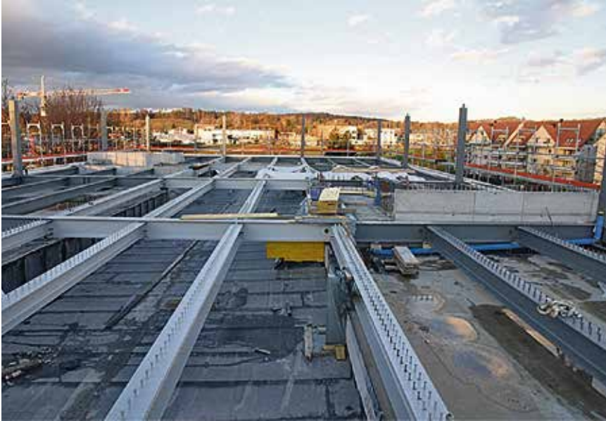
Für die beiden neuen Geschosse auf Trakt A und C wurden im Dezember/Januar grosse Stahlträger verbaut. Hier der Blick auf das neue, zweite Obergeschoss im Trakt A.
