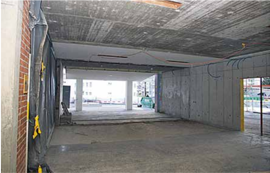
Blick in den neuen Eingangsbereich im Trakt A – der Wegfall der mittigen Treppe schafft mehr Raum.
