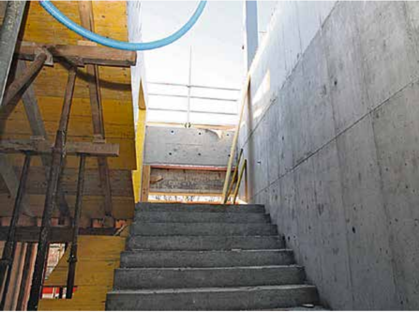
Eine der beiden neuen Treppenanlagen im Trakt A.
