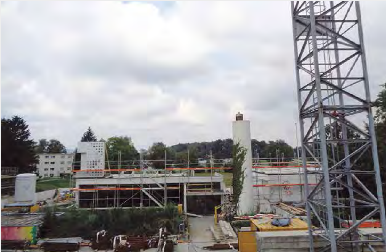
Blick auf den Zwischenboden für die neue Turnhalle auf Trakt C. Das Fassadenmuster (links) zeigt, wie sich die Aufstockungen von aussen präsentieren werden. Fotos: Hugo Engeler
