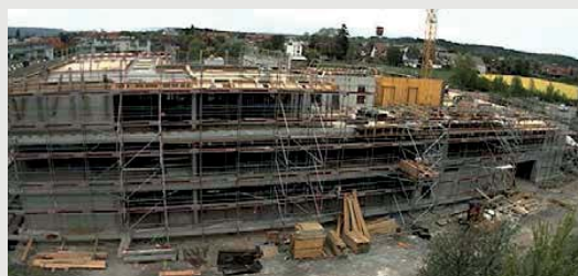
In wenigen Monaten wird die Baustelle abgerüstet sein und sich wie auf dem Symbolbild präsentieren.
