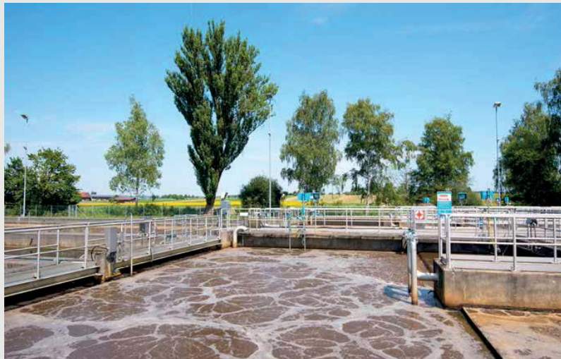
Biologiebecken, Mikroorganismen bauen die organischen Inhaltsstoffe ab.
